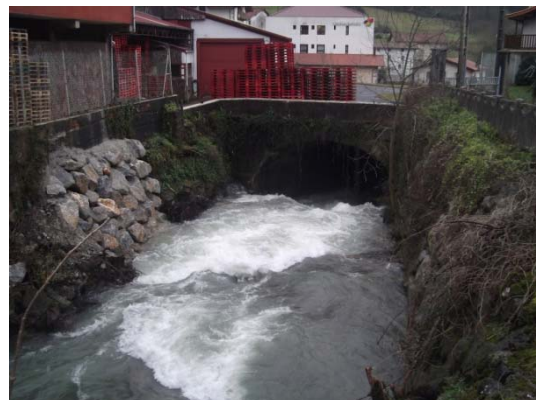
Entrada a la galería y azud anterior
