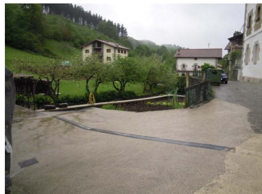
c/Antigua y cauce hacia aguas abajo
