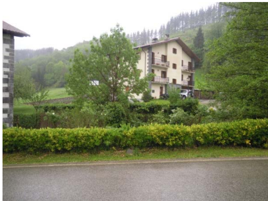
Casa margen izquierda desde estribo derecho
