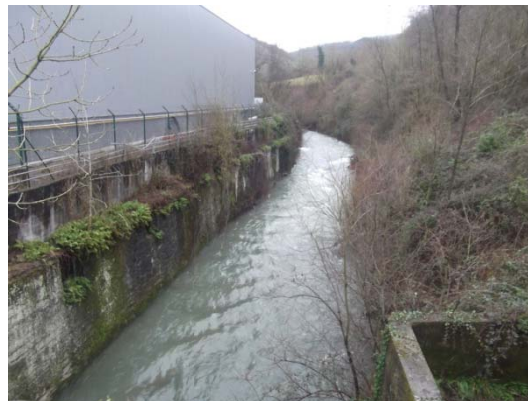
Cauce en el tramo de la fábrica
