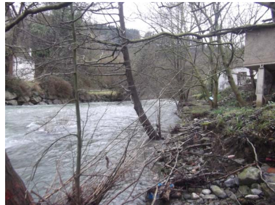
Margen derecha aguas abajo de la galería
