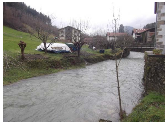
Pasarela peatonal desde acceso al río
