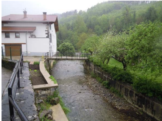
Pasarela vista desde aguas abajo
