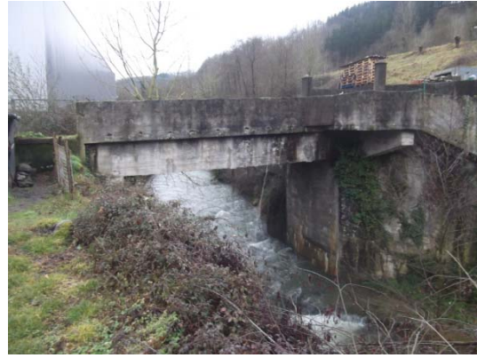
Vista aguas abajo de la pasarela
