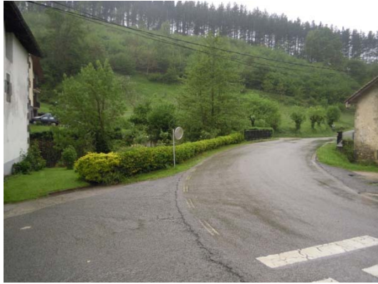
Puente carretera NA-7513 a Intza
