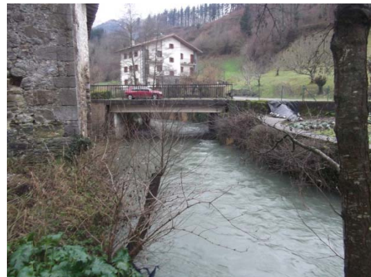
Vista del puente desde aguas abajo
