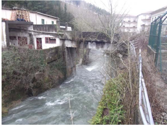
Vista aguas arriba de la pasarela
