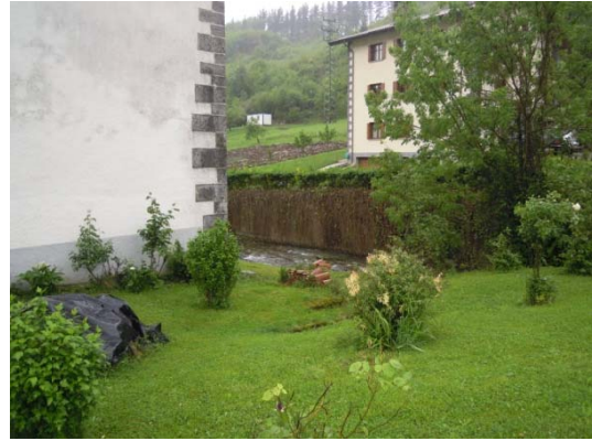
Cauce hacia aguas arriba desde el estribo derecho
