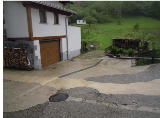
Estribo derecho pasarela, punto bajo
