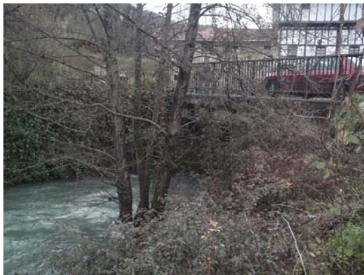
Vista del puente desde aguas arriba
