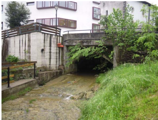
Salida soterramiento regata Ipintza
