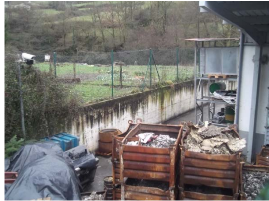
Detalle cierre sureste de la fábrica y nivel del interior
